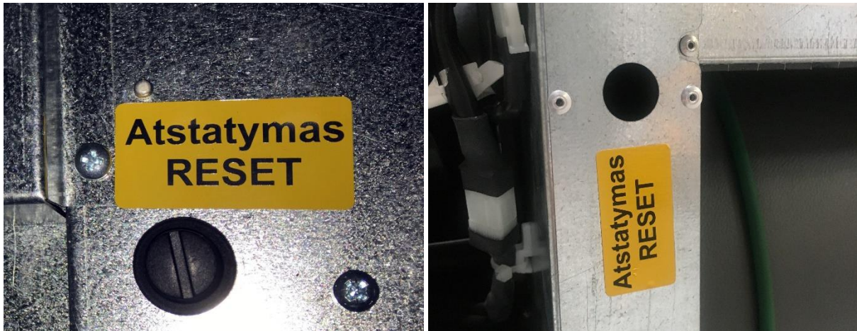
Rys. 3 Oznaczenie miejsca lokalizacji RESET'u manualnego zabezpieczenia termicznego (nagrzewnica zawsze jest zlokalizowana na króćcu powietrza nawiewanego, wyjątkiem są centrale z wymiennikiem przeciwprądowym (Domekt CF) gdzie są zamontowane dwie nagrzewnice, druga tj. nagrzewnica wstępna zlokalizowana jest na króćcu powietrza czerpanego)
