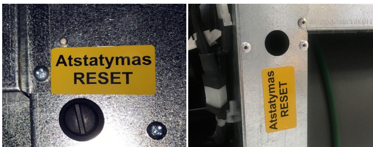
Rys. 4 Oznaczenie miejsca lokalizacji RESET'u manualnego zabezpieczenia termicznego (nagrzewnica zawsze jest zlokalizowana na króćcu powietrza nawiewanego, wyjątkiem są centrale z wymiennikiem przeciwprądowym (Domekt CF) gdzie są zamontowane dwie nagrzewnice, druga tj. nagrzewnica wstępna zlokalizowana jest na króćcu powietrza czerpanego)
