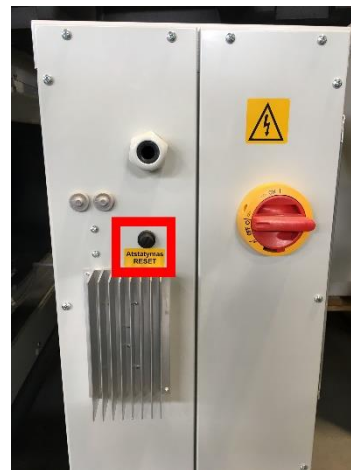
Rys. 3 Oznaczenie miejsca lokalizacji RESET'u manualnego zabezpieczenia termicznego (nagrzewnica zawsze jest zlokalizowana na króćcu powietrza nawiewanego)
