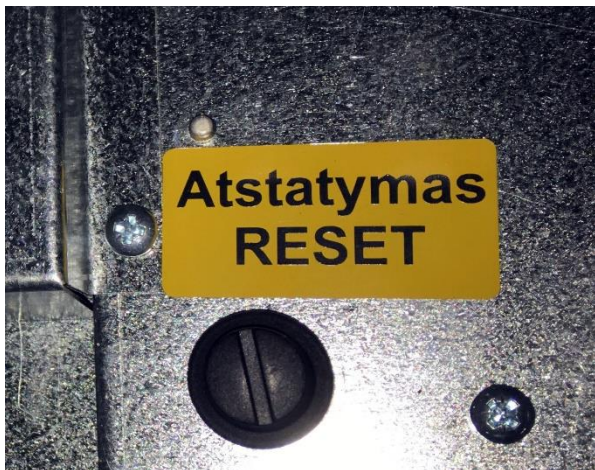
Rys. 3 Oznaczenie miejsca lokalizacji RESET'u manualnego zabezpieczenia termicznego (nagrzewnica zawsze jest zlokalizowana na króćcu powietrza nawiewanego)
