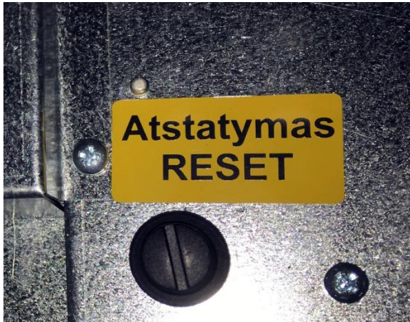
Rys. 1 Oznaczenie miejsca lokalizacji RESET'u manualnego zabezpieczenia termicznego (nagrzewnica zawsze jest zlokalizowana na króćcu powietrza nawiewanego)
