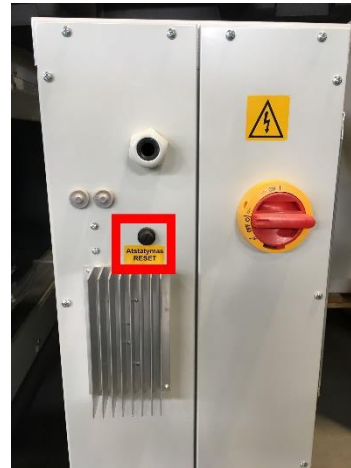
Rys. 1 Oznaczenie miejsca lokalizacji RESET'u manualnego zabezpieczenia termicznego (nagrzewnica zawsze jest zlokalizowana na króćcu powietrza nawiewanego)
